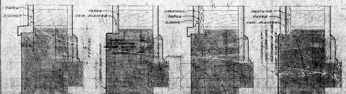
SIDING ON STUDS PLASTER ON STUDS SIDING ON SHEATHING PLASTER ON SHEATHING
